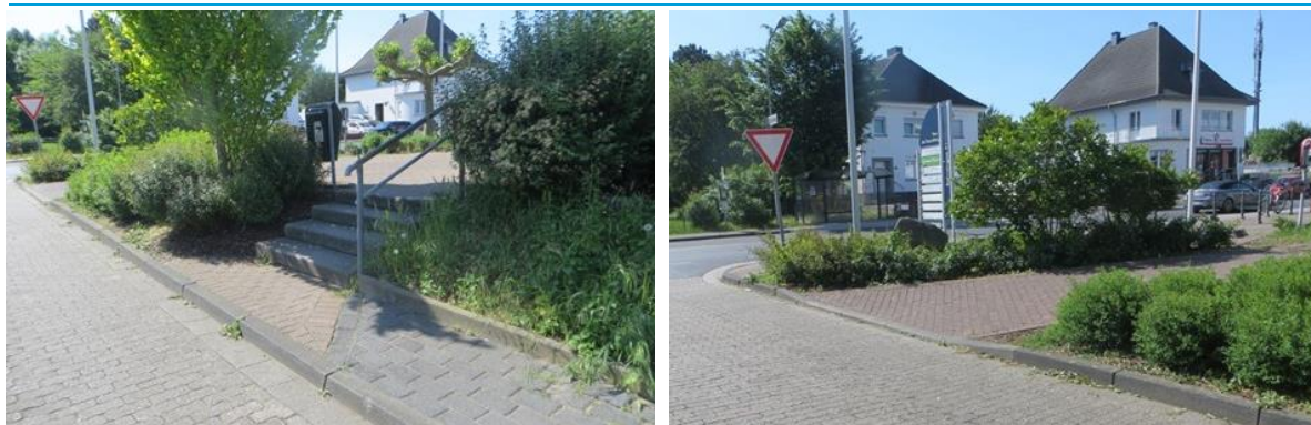
Abb. 11: Stufen zum Vorplatz des Rathauses mit hohem Bord (links), Rampe mit hoher Kante (rechts)
